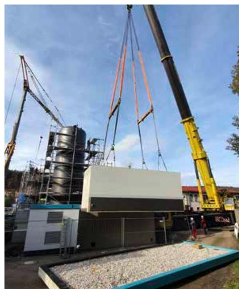
Ein echter Koloss: Die neue Trafostation für das BHKW wiegt 40 Tonnen.
